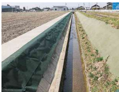
▲コンクリートで舗装した畦畔
