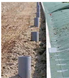
▲施設された暗渠排水
